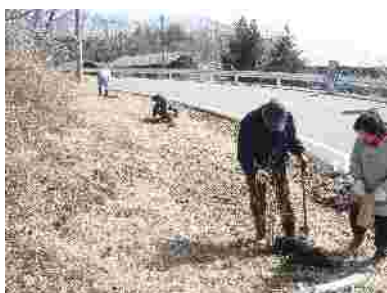
写真 - 1 県農業試験場北側
